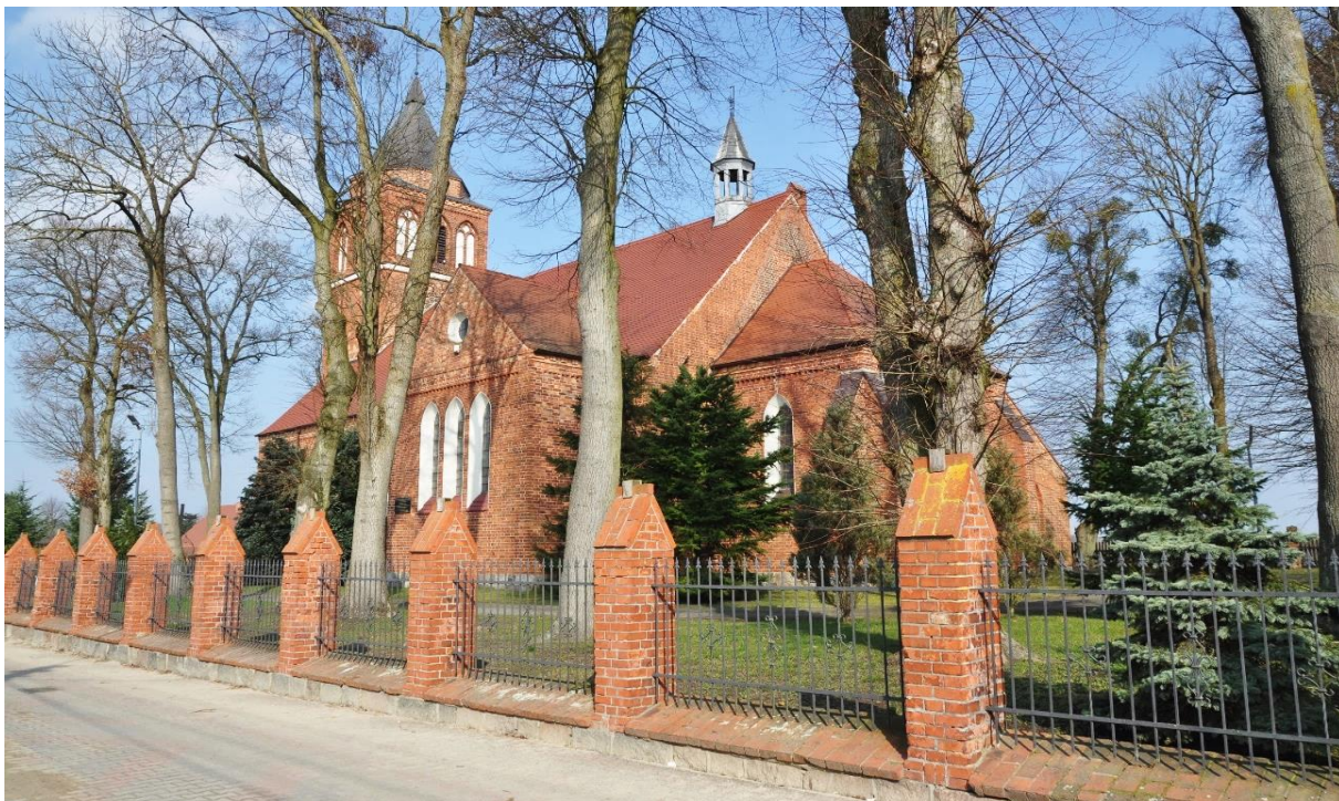
Fot. 4. Widok na kościół od strony południowo-wschodniej.
