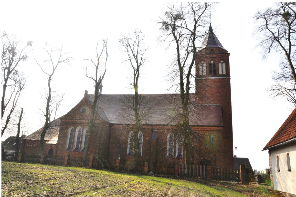
Fot. 6. Elewacja północna.
