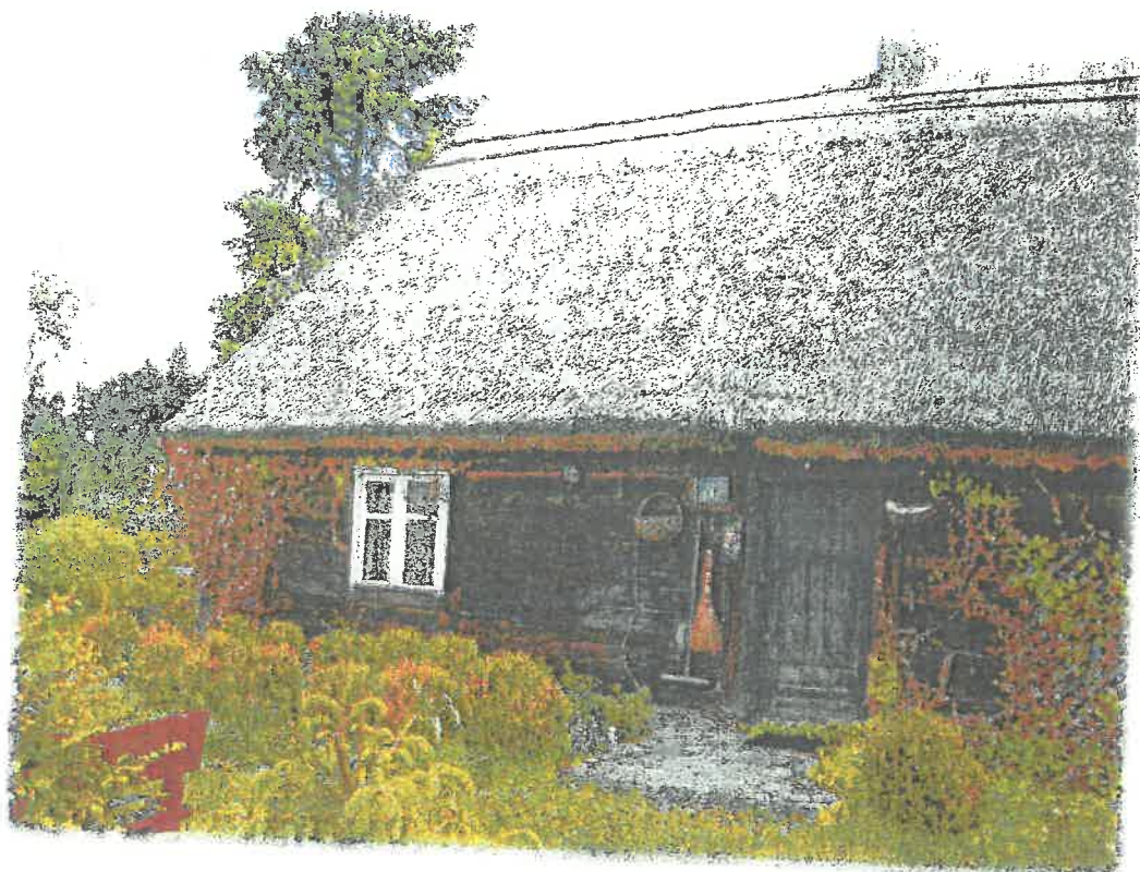
zdj. 3 – elewacja północna
