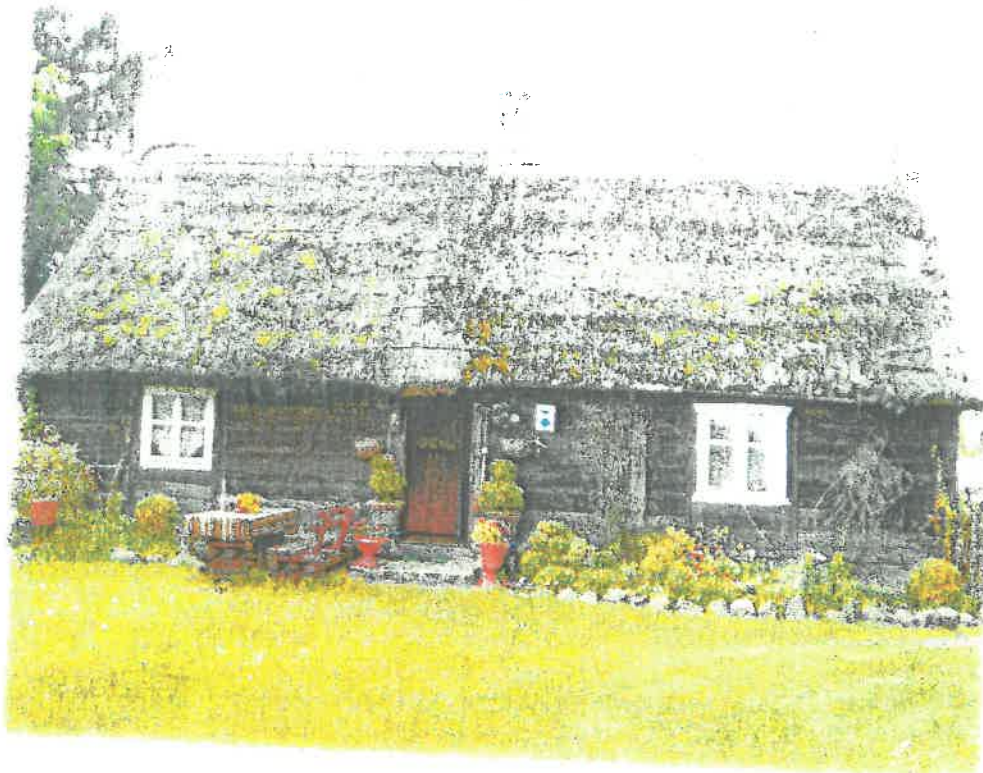
zdj. 1 – elewacja południowa
